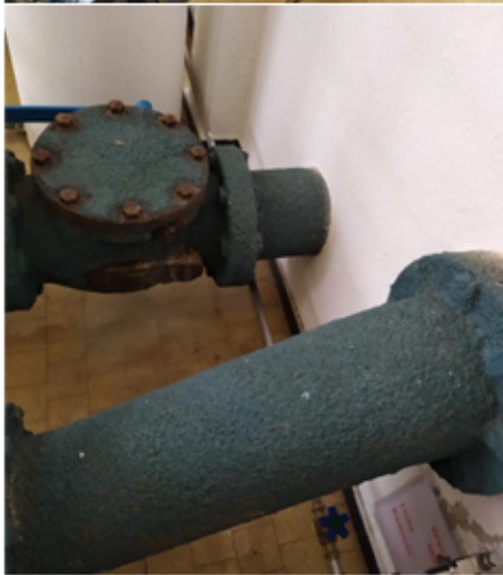
Löschklappe, Schieber, Verrohrung, Ausgleichsleitung sowie Probenahmeahn
