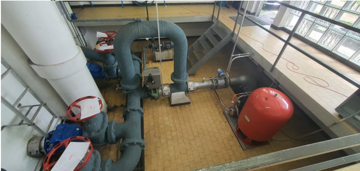
Abb. 8: Erdungssituation im Rohrkeller
