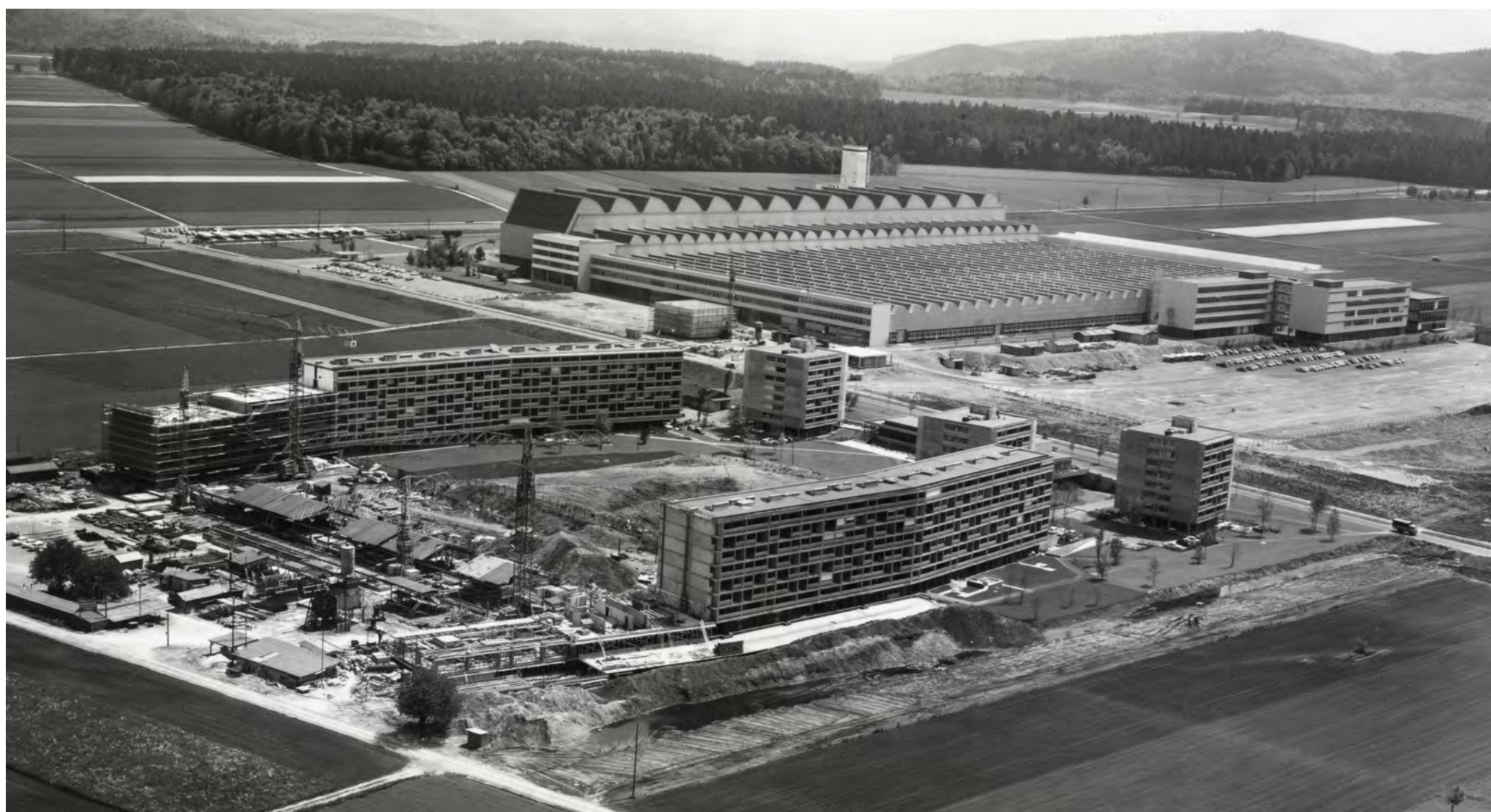
Siedlung Wyde (Birr) im Bau, im Hintergrund: BBC (Brown, Boveri und Compagnie) und das Birrfeld
